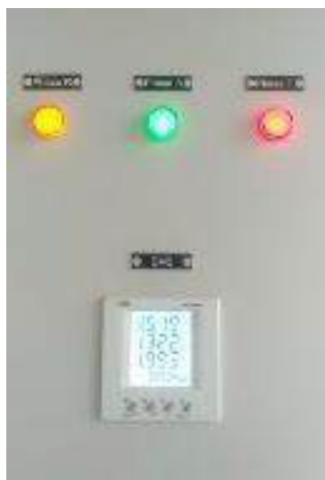
Hình 3.5. Đồng hồ đo điện, đo lưu lượng nước thải sau xử lý
