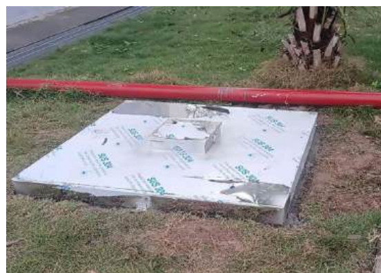
Hình 3.21. Bể lưu chứa chất thải nguy hại lỏng có nguy cơ đổ tràn
