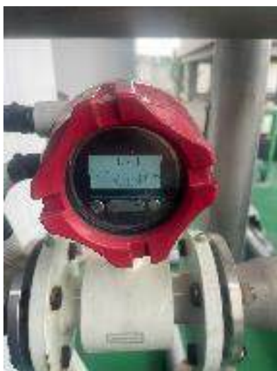
Hình 3.5. Đồng hồ đo điện, đo lưu lượng nước thải sau xử lý
